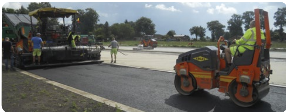
De werkzaamheden voor sportpark Heikant draaien op volle toeren.
