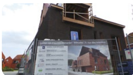
De bouwwerken in de Withoeflei.
