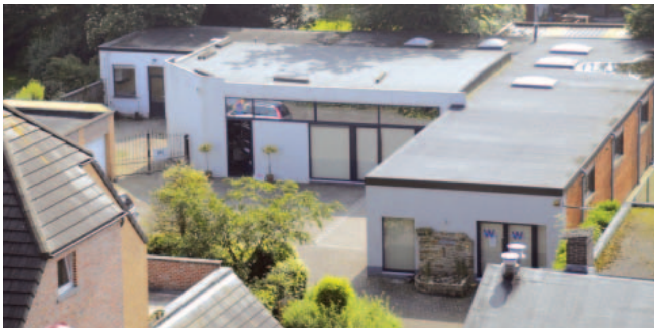
Het bedrijfsgebouw, pal in het centrum van de gemeente, waar straks het dienstencentrum van het OCMW wordt ingericht.
