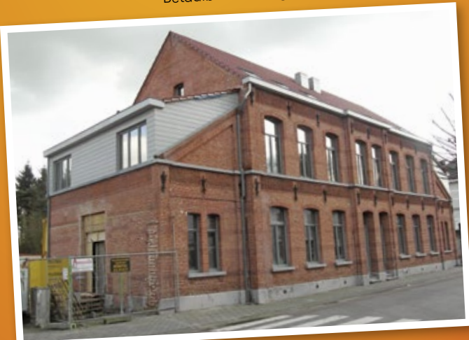
Sociale woningen langs de Kapellensteenweg.
